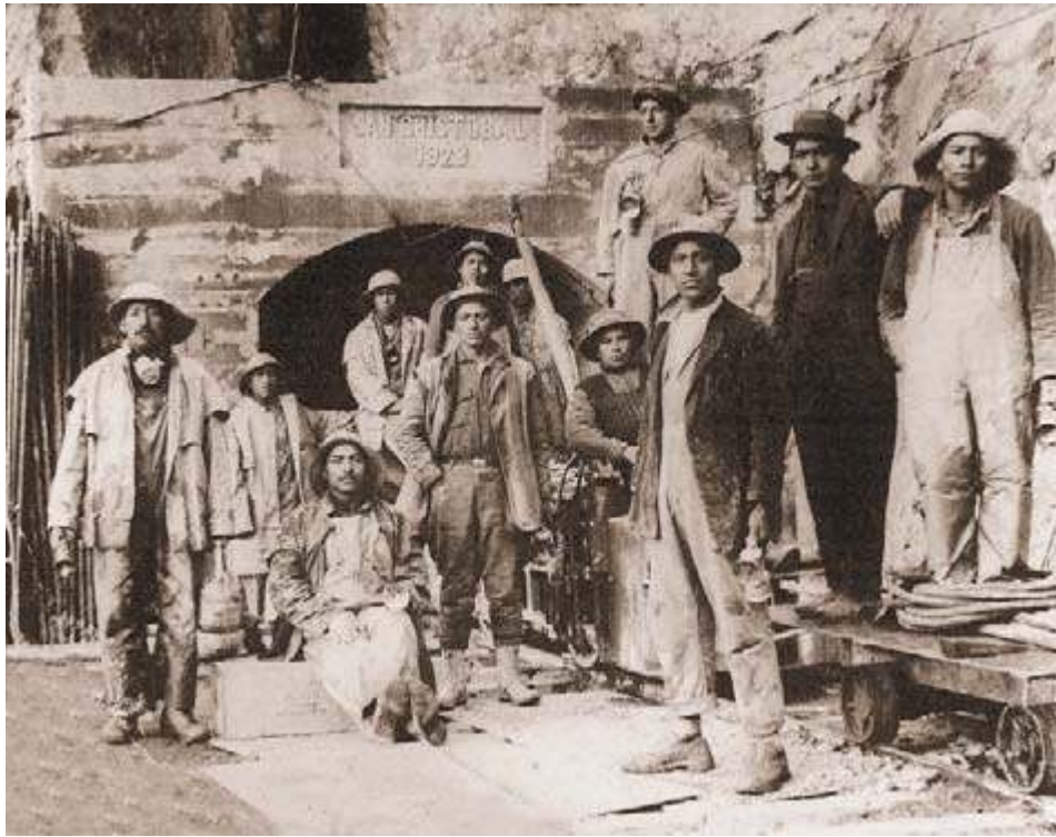
Los mineros de Morococha en el ingreso a la mina de San Cristóbal.
